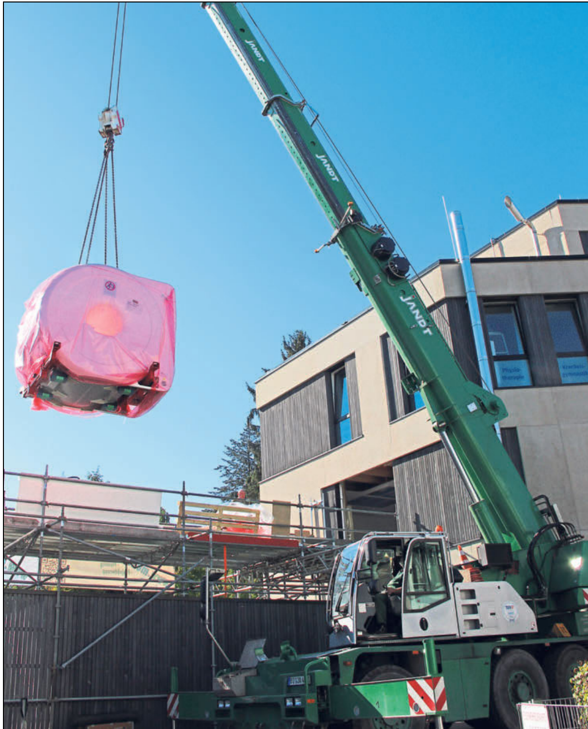
Schwergewicht: Der 4,5 Tonnen schwere MRT wurde in mühevoller Millimeterarbeit durch ein ausgebautes Fenster in die erste Etage des Ärztehauses gehoben. Foto: Diranuk
